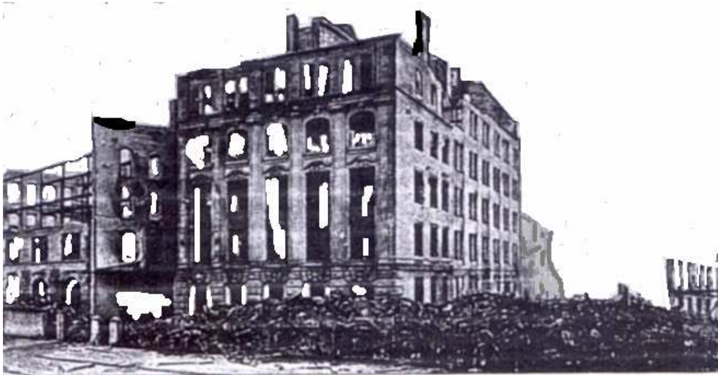
Die Reste der TN in der Mainzerlandstrasse.
