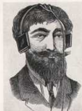
Abb. 141 Ein statisches Telefon als Bügel-Kopfhörer ausgebildet, System Delmont
