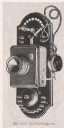
Bild 125: Kurbelfernsprechapparat aus der Mitte der 80er Jahre. Dem Redakteur war damals der Fernsprechapparat noch so wenig bekannt, daß er diesen neuen Apparat auf dem Kopf stehend abbildete.
