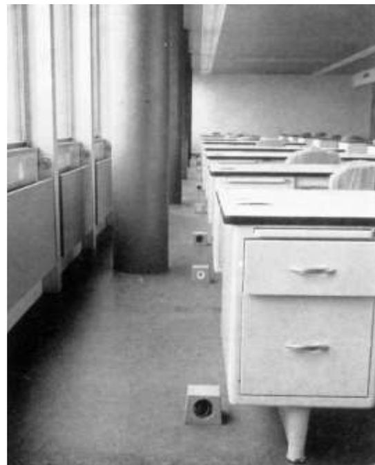
Zusammen mit der Firma Ackermann, Gummersbach wurden dann für die Aufnahme von Starkstrom Steckdosen und Anschlüssen der Schwachanlagen spezielle Telefon- Licht- Anschlussstellen sogenannte Teli-Tanks entwickelt. Diese Teli-Tanks verschiedener Bestückung und Größen konnten auch die neuen TN-Verteiler mit 6 Lötleisten aufnehmen.
