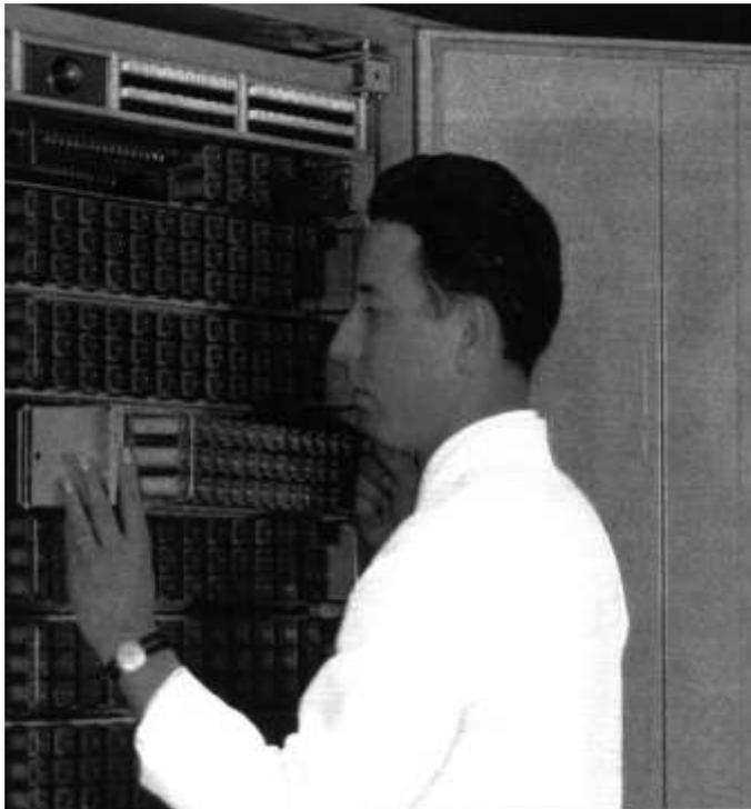
*Zentralen der Baustufe III eine Schrankbauweise nach einem konsequent geplanten Bausteinsystem entwickelt.*
