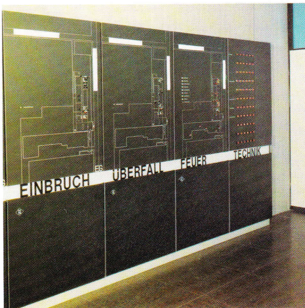
Anzeigetableau zur schnellen Lokalisierung von Gefahrenmeldungen
