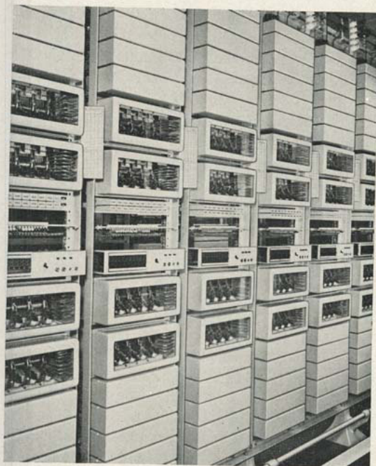
BILD 386 Gestellreihe mit Misch- wählern mit Umsteuerung (MWmU)
