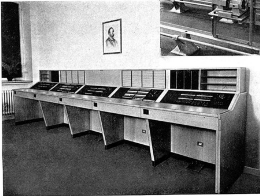
Wählergestelle der TuN Dinewa-Zentrale (Direktnebenstellen-Wählanlage) für 80 Amtsanschlüsse, 57 Querverbindungen und 700 Hausanschlüsse
