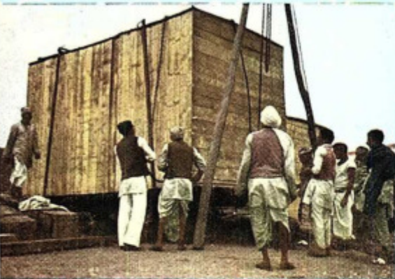
Abladen eines Großbehälters („Liftvan“) mit primitiven Hebezeugen.
