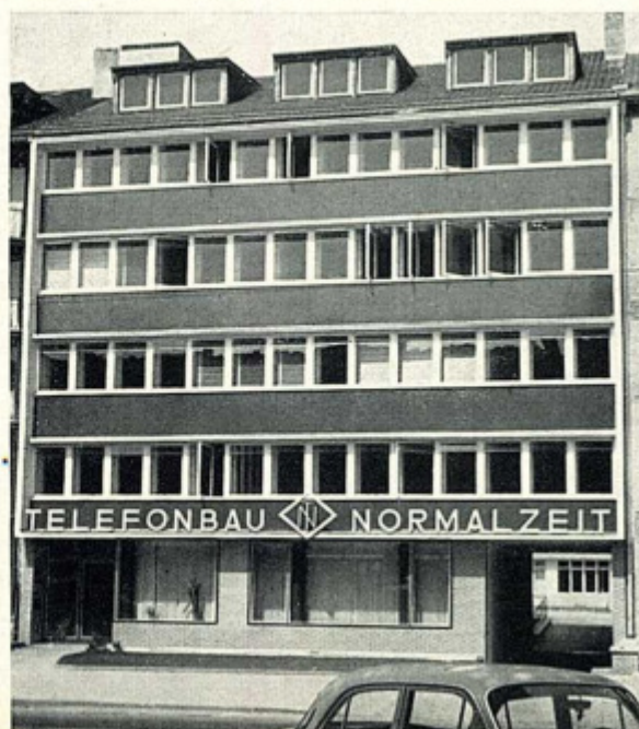
Neubau unseres Verwaltungsgebäudes in Düsseldorf
