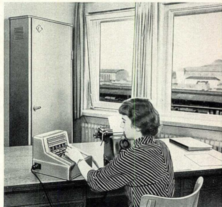
Die neue TuN-Universalzentrale im Büroraum
