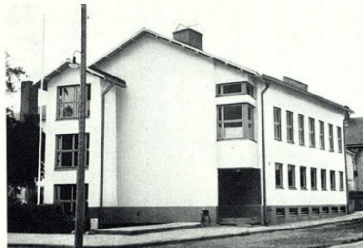
Hauptamtsgebäude Vammala mit TuN-Wählamt für 800 Teilnehmer
