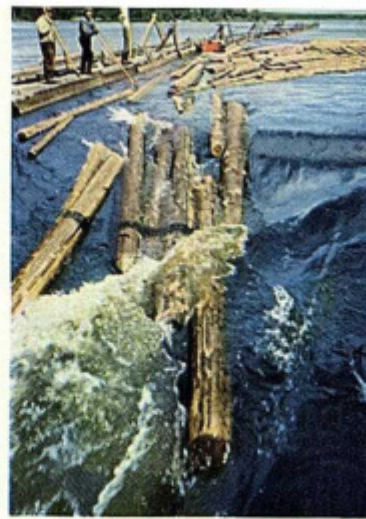
Staustufe mit Holzrutsche für Baumstämme
