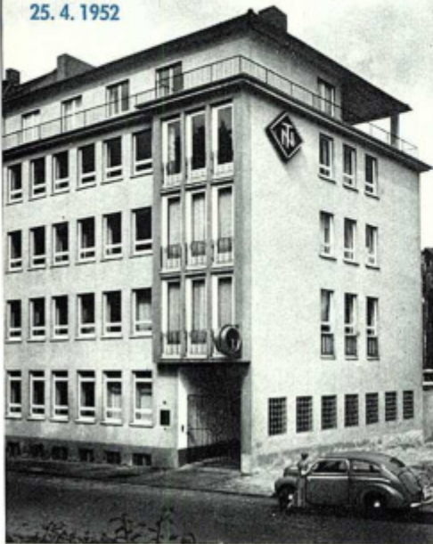
Bild 2 Geschäftshaus des Verwaltungsbezirks Hannover, Hannover, Volgersweg 36
