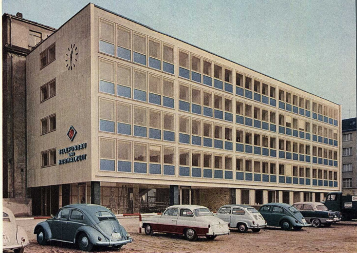
Das neue Verwaltungsgebäude
