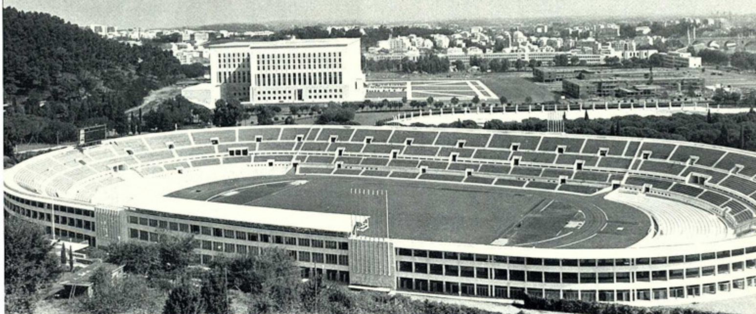
Bild 3 Verwaltungsgebäude des Olympischen Komitees
