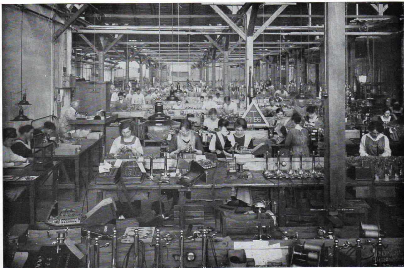
Abb. 20. Teilansicht des Montagesaales
