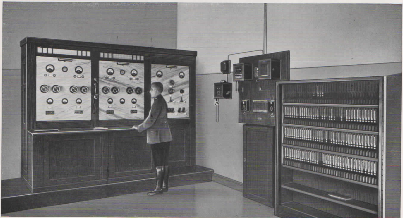
Abb. 1. Empfangszentrale für 4 Schleifenleitungen und Typendruckregistrierung nebst Telefon- und Prüfeinrichtung, sowie Schlüsselschrank der Polizei-Notruf-Anlage in Kassel
