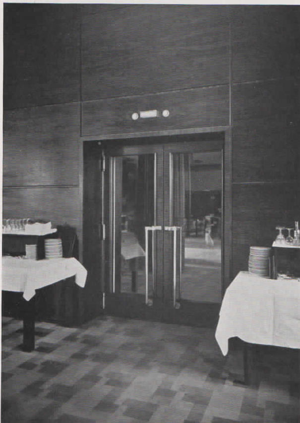
Abb. 5. Lichtsignal-Tablo und Fuld-Fernsprecher in einer Office im Palast-Hotel Mannheimer Hof, Mannheim.
