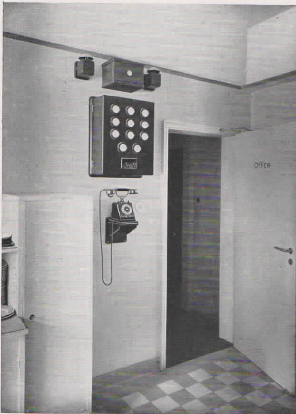
Abb. 5. Lichtsignal-Tablo und Fuld-Fernsprecher in einer Office im Palast-Hotel Mannheimer Hof, Mannheim.
