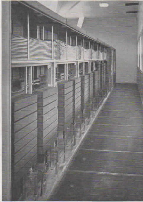
Abb. 12. Rückansicht der Schränke mit Vielfachverkabelung im Rathaus Frankfurt a. M.
