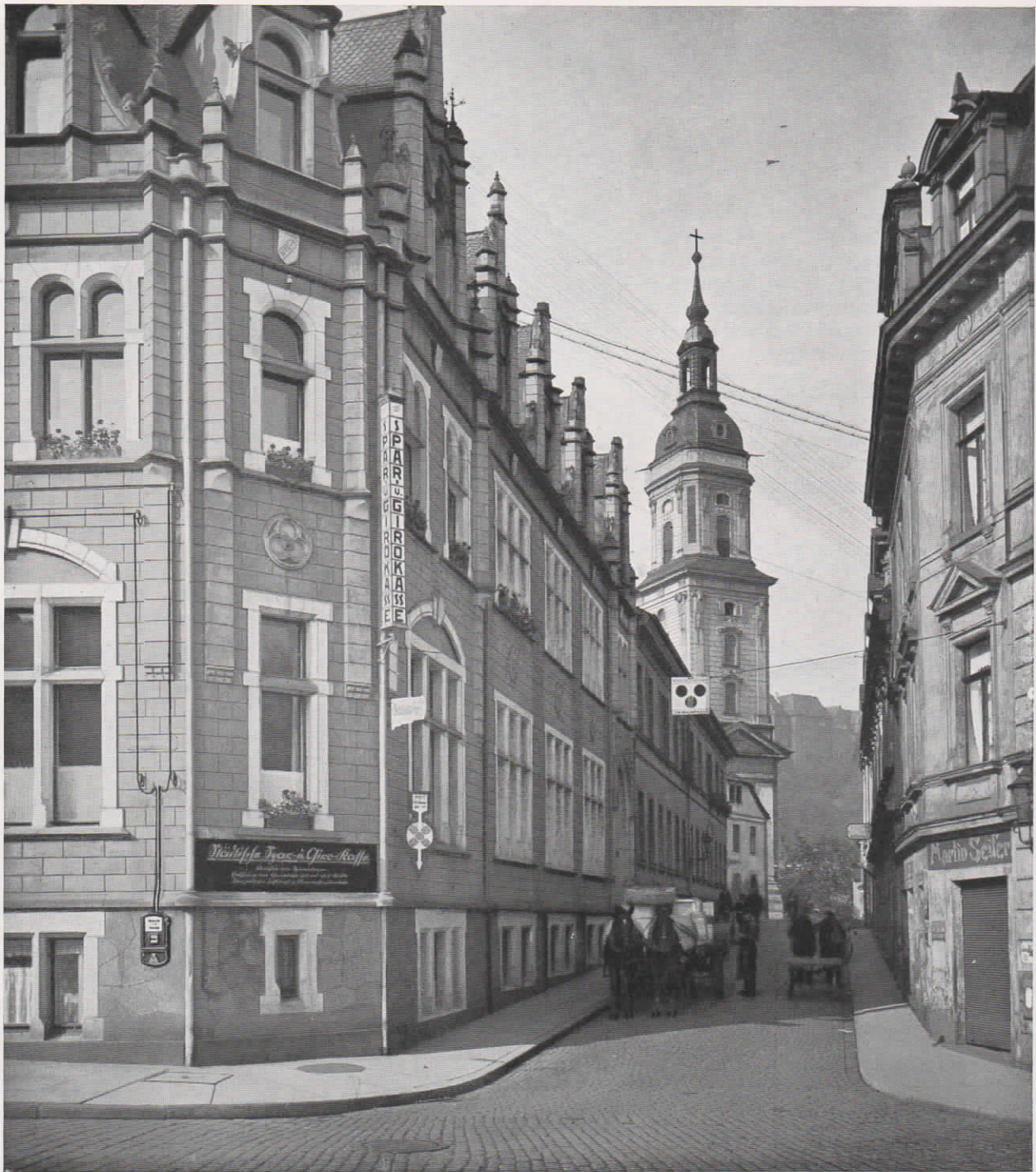
Abb. 5. Feuermelder mit Leitungszuführung in Greiz
