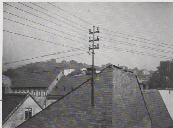
Abb. 4. Dachständer für die Freileitungsanlage.
