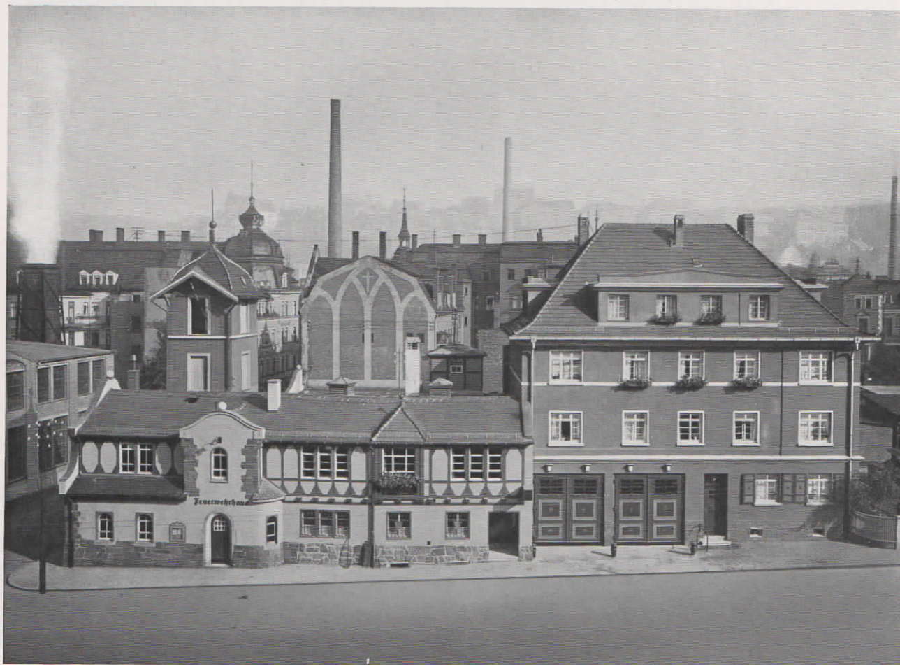
Abb. 1. Neues Feuerwehrhaus mit Geräte-Depot in Greiz.
