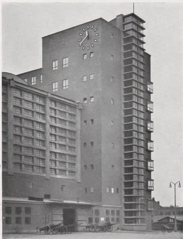
Abb. 1. Turmuhr mit Leuchtzeigern und Leuchtzifferstrichen (Tagaufnahme) in der Städtischen Großmarkthalle zu Frankfurt a. M.
