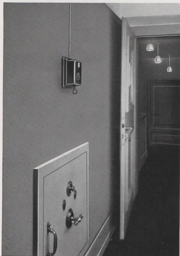
Abb. 4. Notruf-Privatmelder im Kassenraum der Städtischen Sparkasse Kassel
