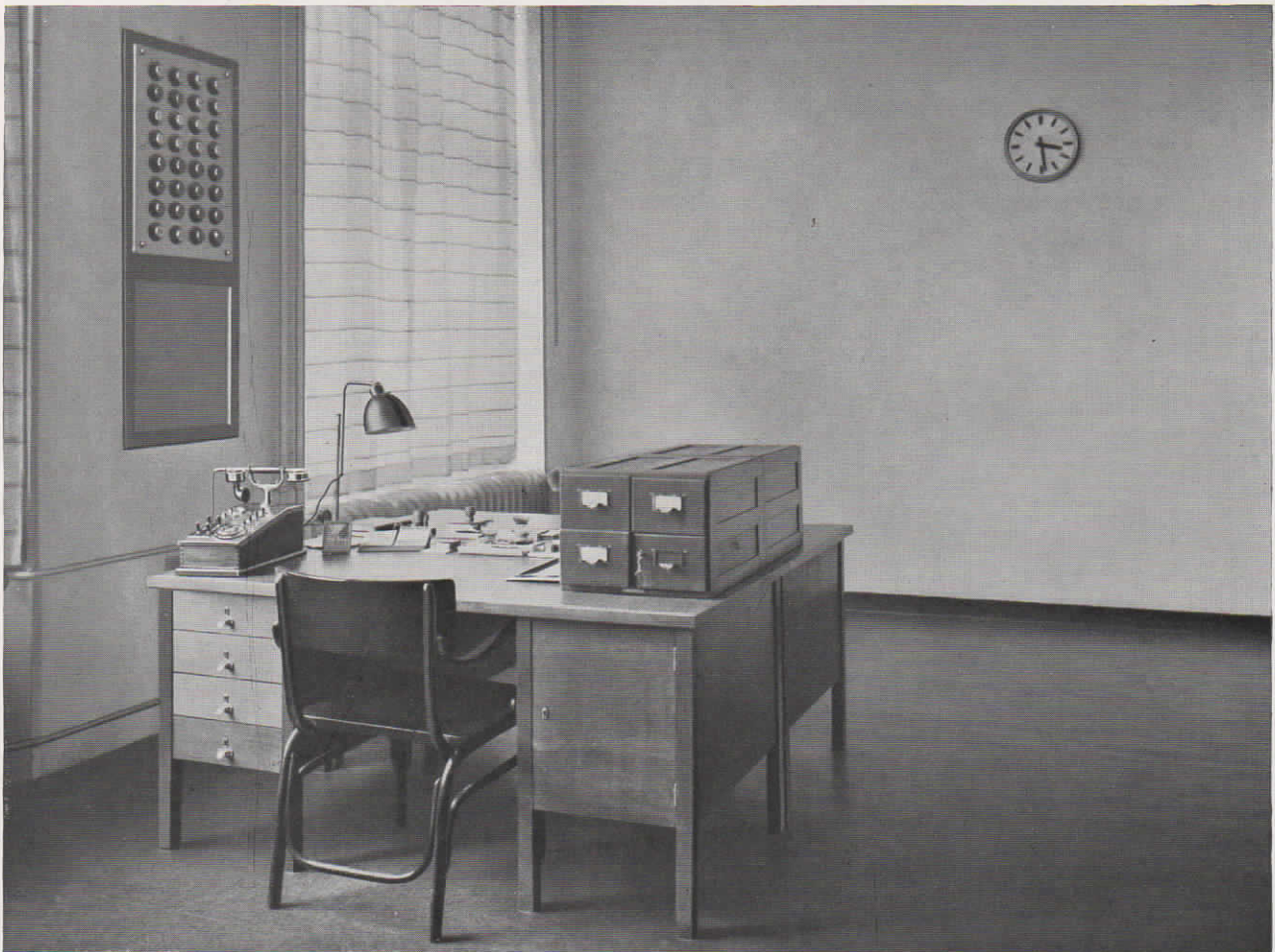
Abb. 19. Büroraum mit Fuld-Fernsprecher, Lichtsignaltaflo und eingebauter Normal-Zeit-Nebenuhr im Röntgenlaboratorium des Städtischen Krankenhauses Frankfurt a. M.
