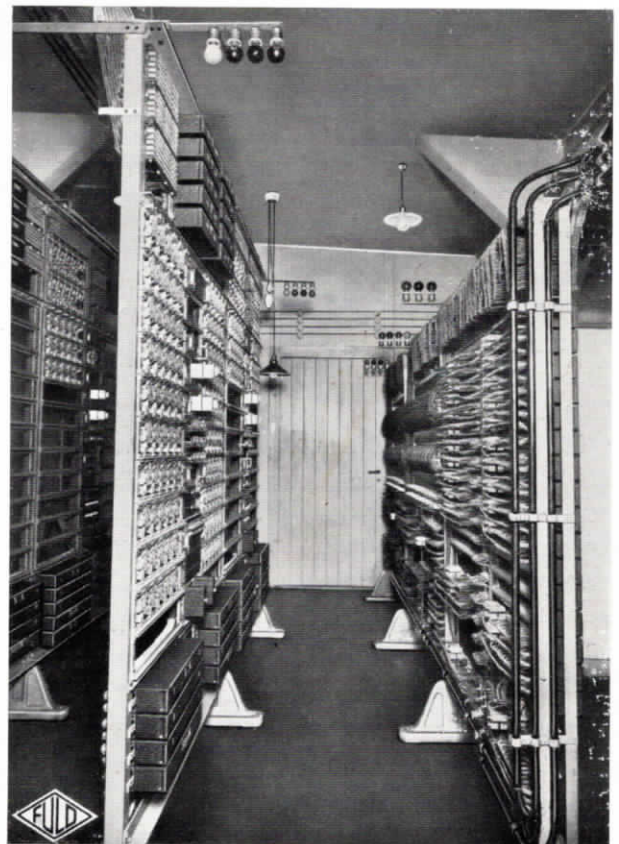
Abb. 32. Wählergestelle für die halbautomatische Nebenstellenzentrale und für die vollautomatische Fuld-Hauszentrale (1000er System) für 120 Teilnehmeranschlüsse
