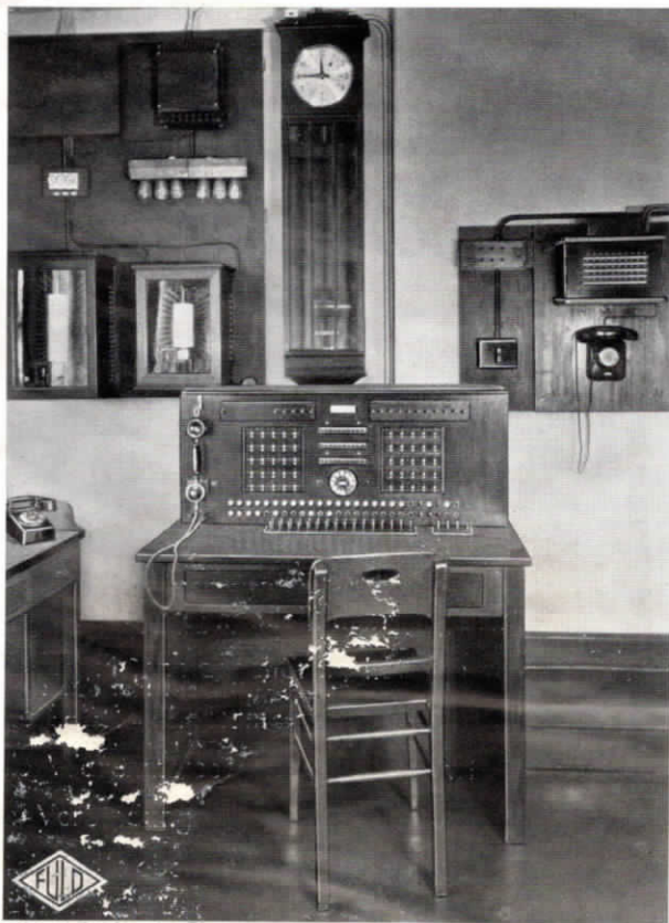
Abb. 23. Halbautomatische Fuld-Fernsprech-Vermittlungszentrale für 15 Amtsleitungen und 150 Nebenstellen in der Stadt- und Girobank in Leipzig
