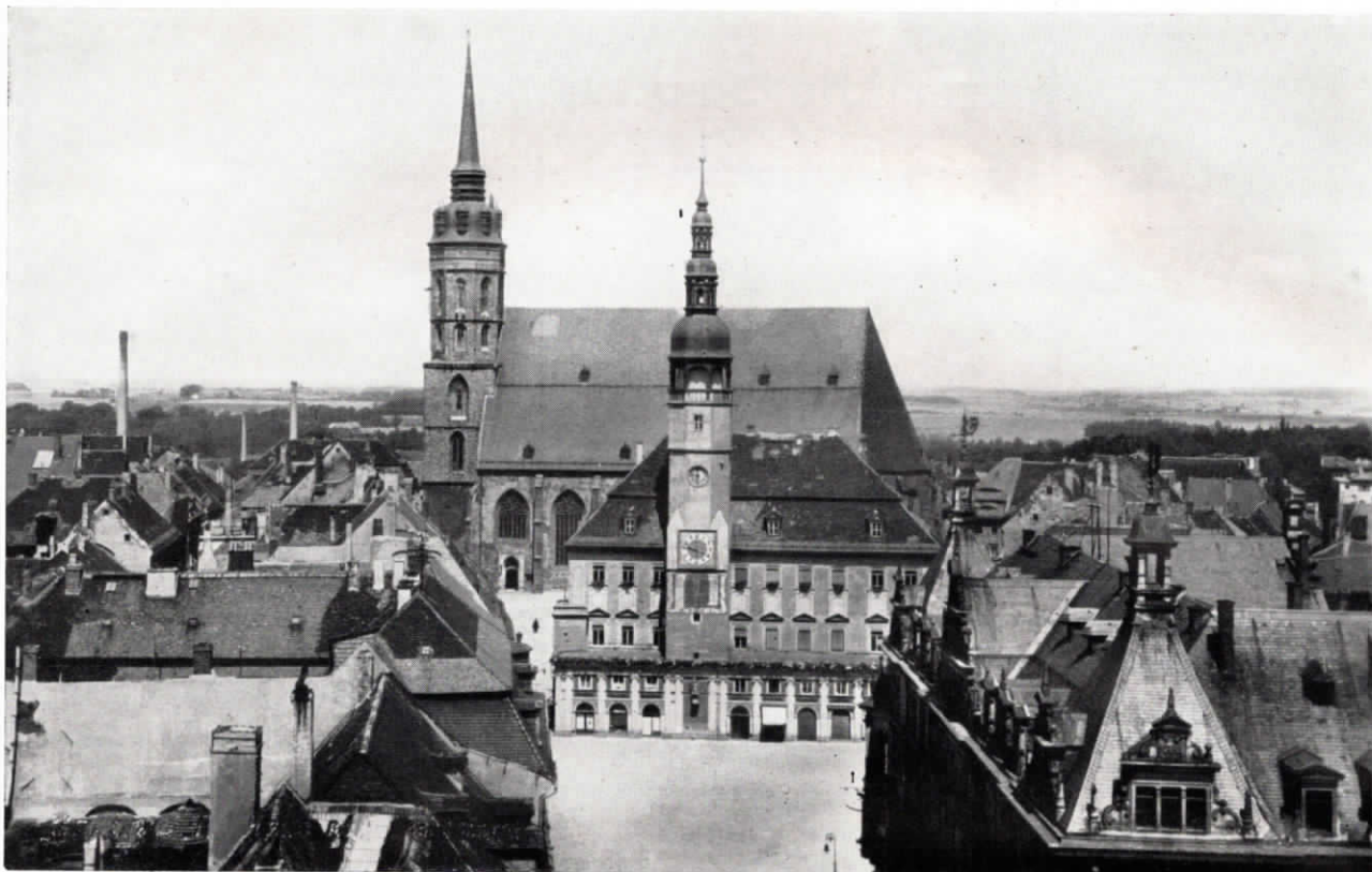
Abb. 2. Das Rathaus mit dem Petri-Dom dahinter, in Bautzen
