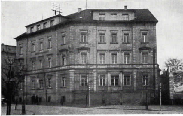
Abb. 54. Die Amtshauptmannschaft in Bautzen besitzt eine Fuld-Fernsprechanlage, bestehend aus einer halbautomatischen Zentrale für 4 Amtsleitungen und 50 Nebenstellen, einer vollautomatischen Zentrale für 70 Teilnehmeranschlüsse für den internen Verkehr, 63 Fernsprechapparaten, darunter ein fahrbarer Apparat „Pufu“
