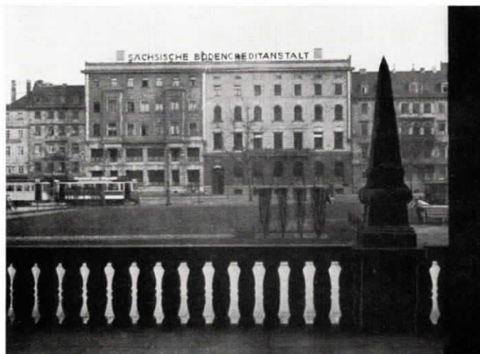
Abb. 17. Die Sächsische Bodencreditanstalt in Dresden bedient sich einer Fuld-Fernsprechanlage, bestehend aus einer Glühlampenzentrale für 5 Amtsleitungen und 30 Nebenstellen; dem internen Verkehr dient eine vollautomatische Zentrale für 50 Teilnehmeranschlüsse
