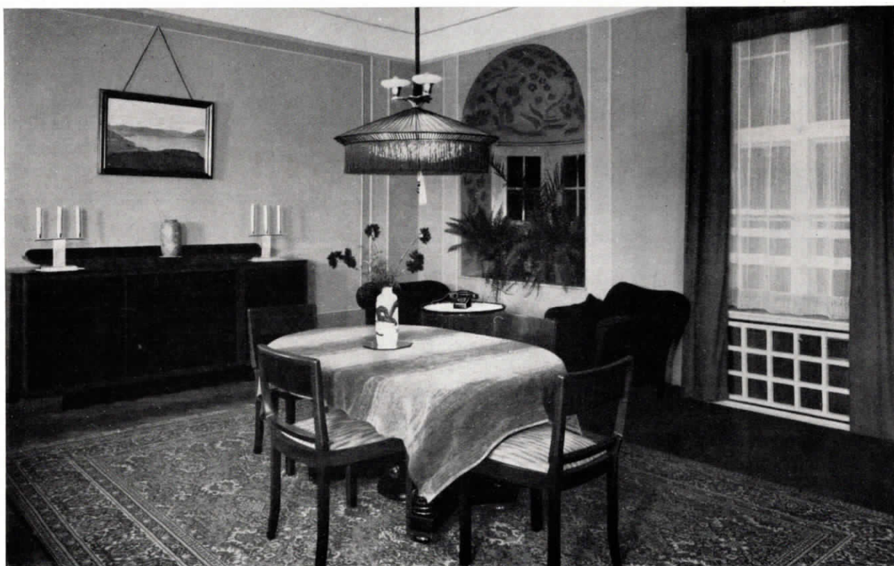
Abb. 32. Speisezimmer mit Fuld-Fernsprecher in einem Dresdner Wohnhaus
