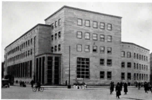
Abb. 1. Die Reichsbankhauptstelle in Dresden
