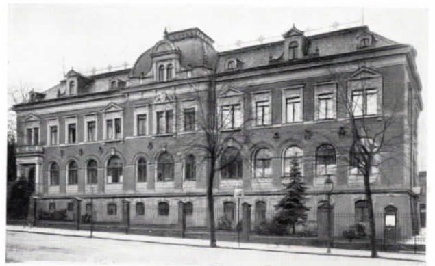
Abb. 56. Die Amtshauptmannschaft Döbeln verfügt über eine Fuld-Fernsprechanlage, bestehend aus einer halbautomatischen Zentrale für 3 Amtsleitungen und 25 Nebenstellen und einer vollautomatischen Zentrale für 30 Teilnehmeranschlüsse für den internen Verkehr
