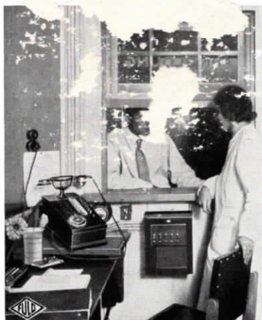
Abb. 19. Bedienungsschalter der Fuld-Universalzentrale für 3 Amtsleitungen und 55 Nebenstellen (ausbaufähig für 8 Amtsleitungen u. 100 Nebenstellen); dem internen Verkehr dient eine vollautomatische Fuld-Zentrale für 60 Teilnehmer, in der Zigarettenfabrik W. Lande in Dresden
