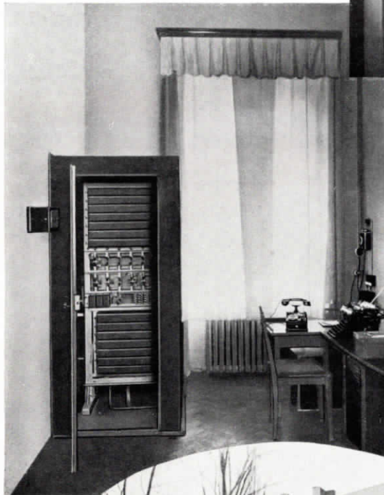
Abb. 42. Die Amtshauptmannschaft Freiberg i. S. besitzt eine Fuld-Fernsprechanlage, bestehend aus einer Universalzentrale für 3 Amtsleitungen und 26 Nebenstellen
