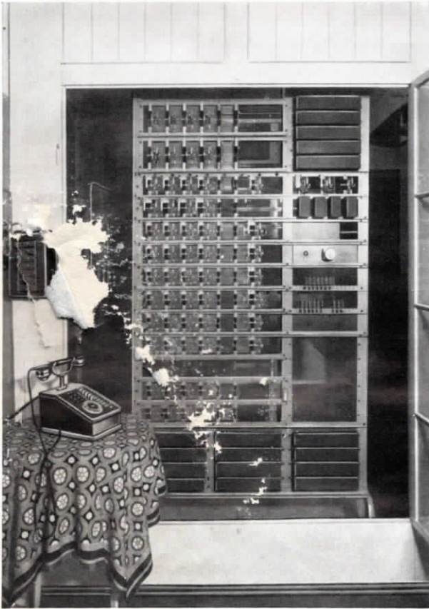
Abb. 5. Vollautomatische Fuld-Fernsprech-Unterzentrale im Städtischen Krankenhaus
