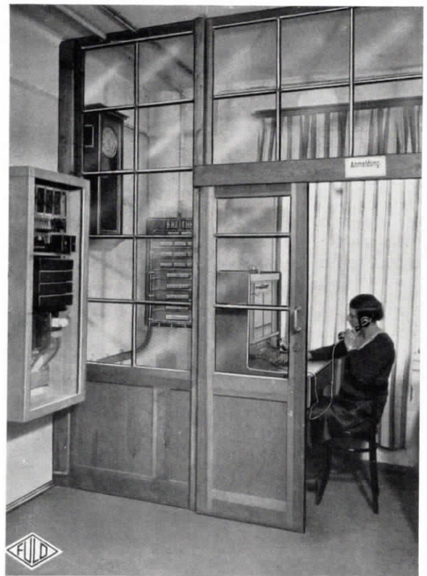
Abb. 59. Fuld-Fernsprechzentrale, bestehend aus einer halbautomatischen Zentrale für 4 Amtsleitungen und 20 Nebenstellen und einer vollautomatischen Zentrale für 30 Teiln. für den Hausverkehr, ferner Normalzeit-Hauptuhr in den Kremer-Zigarettenwerken G. m. b. H. in Döbeln
