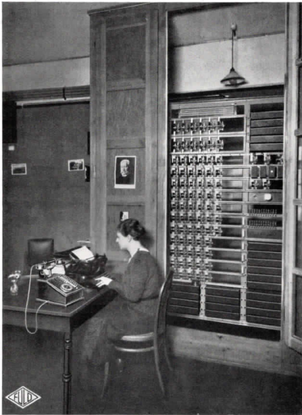
Abb. 33. Die Amtshauptmannschaft Löbau bedient sich einer Fuld-Universal-Fernsprechanlage für 4 Amtsleitungen und 30 Nebenstellen
