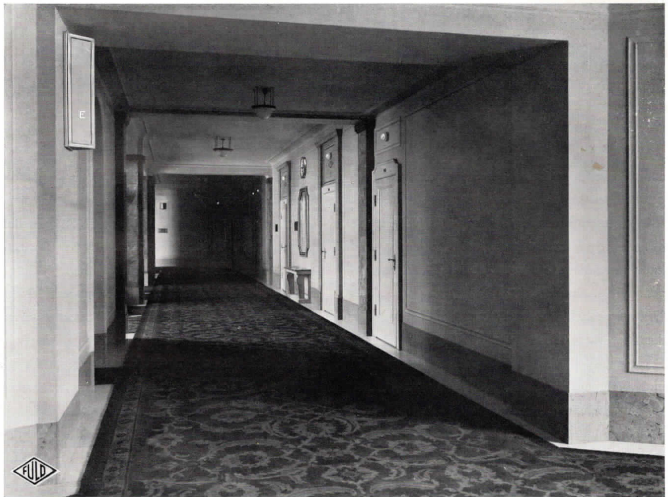
Abb. 4. Flur im Hotel Astoria in Leipzig mit Fuld-Lichtsignalapparaturen (Zimmerlampen über den Türen, und Gruppen- und Etagentablos links im Vordergrund an der Wand). Die Lichtsignalanlage erstreckt sich über 220 Zimmer
