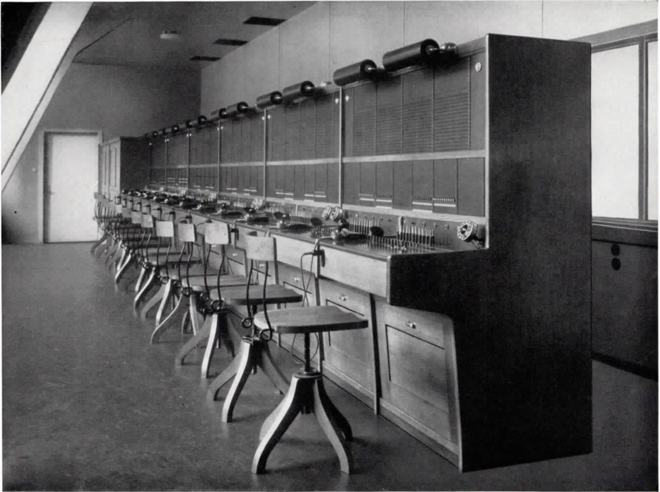
Abb. 21. 12-pläßige Glühlampenzentrale für halbjelbsttätigen Betrieb, Rathaus Frankfurt a. M. (vergl. Abb. 7)
