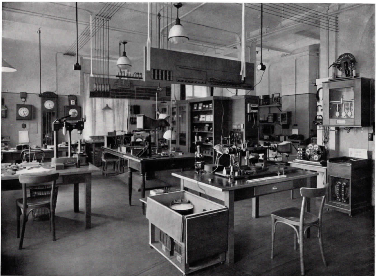
Fernmeldetechnisches Hauptlaboratorium, Wert Mainzerlandstraße
