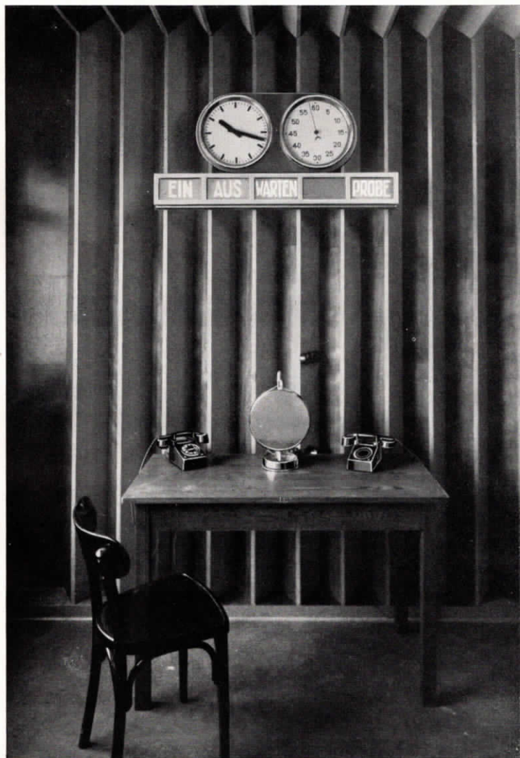
Abb. 4. Signaltablo, elektrische Uhren, Gong, Telefonapparate für Post- und Hausverkehr und Betriebstelefon im Sprechraum des Reichssenders Königsberg i. Pr.
