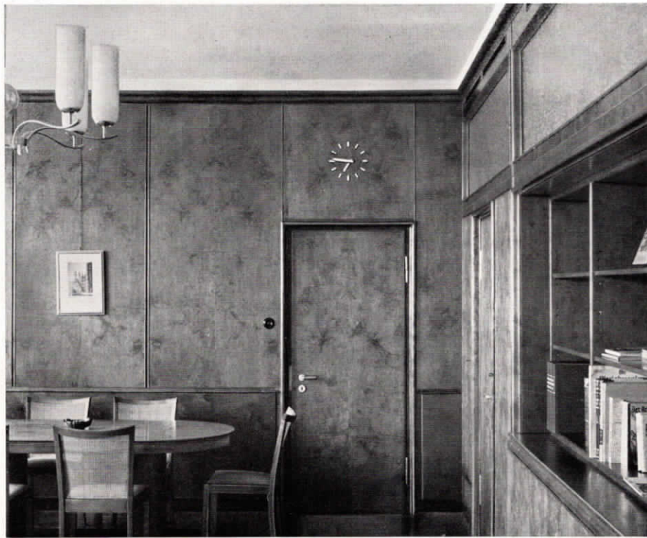
Abb. 4. Nebenuhr in die Wandtäfelung eingelassen.
