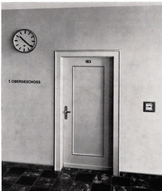
Bild 7 Flur mit elektrischer Nebenuhr und Feuermelder
