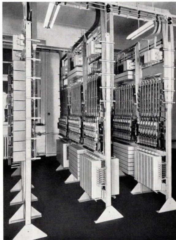
Abb. 4 Blick in den Wählerraum mit den Gestellen der Nebenstellenanlage für 300 Teilnehmer nach dem »Rekord«-System (Fallwähler)
