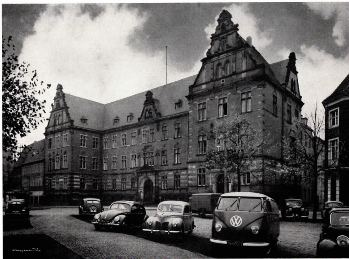
Abb. 1 Das Regierungsgebäude in Münster i. W.
