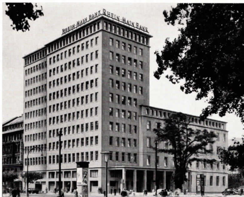
Abb. 1 Verwaltungsgebäude der Rhein-Main Bank in Frankfurt a. M.
