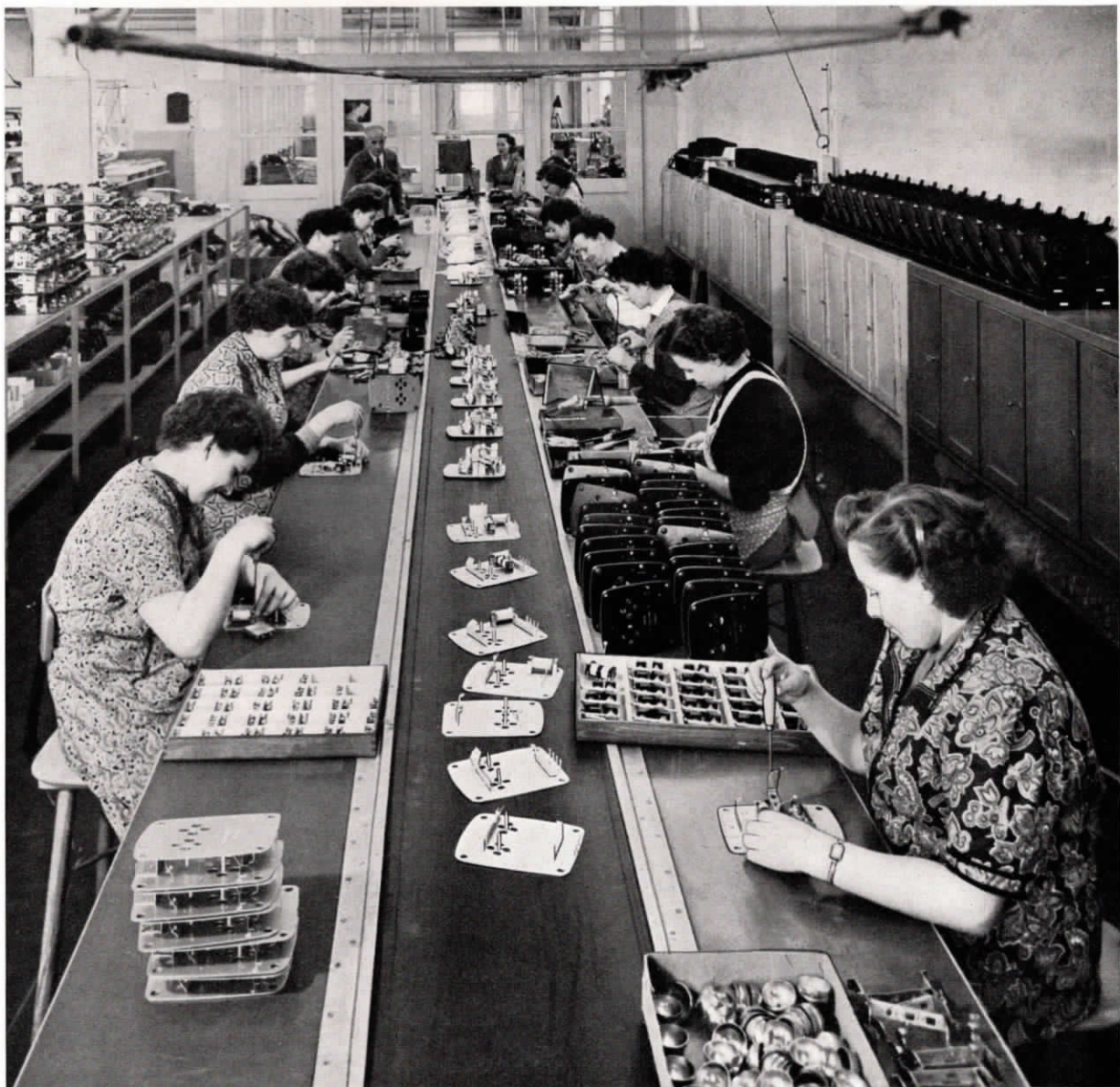
Aus unserer Fabrikation: Fließbandfertigung von Telefonapparaten
