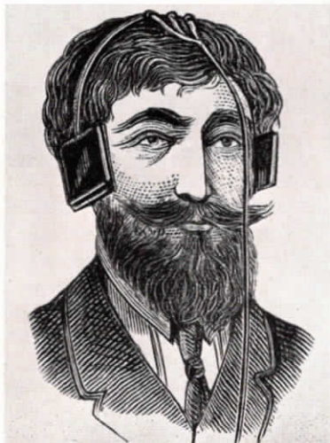
Abb. 141 Ein statisches Telefon als Bügel-Kopfhörer ausgebildet, System Delmant
