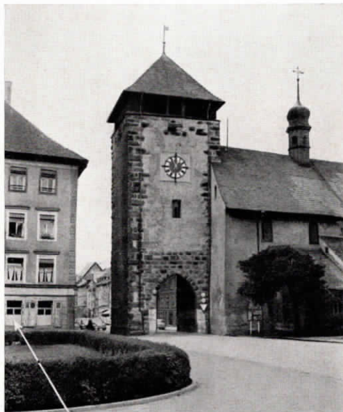
Abb. 1 In unmittelbarer Nähe des historischen Bickentores in Villingen ist die Feuermelde-, Unfall- und Alarm-Zentrale untergebracht
