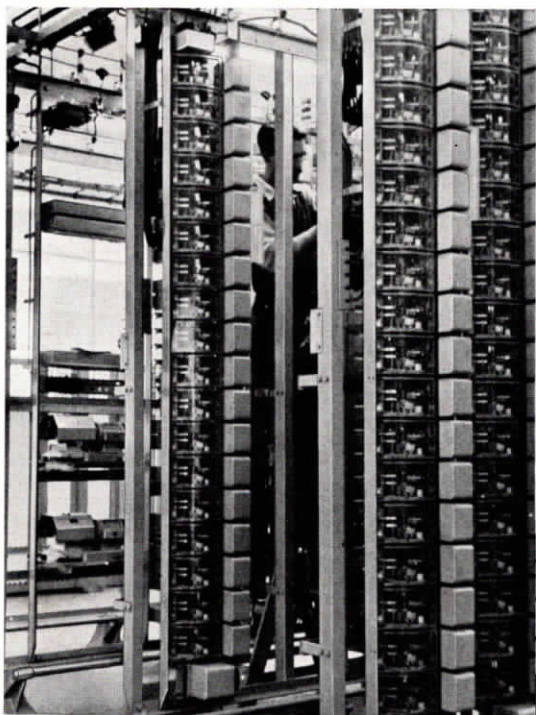
Abb. 3 Gestellreihe mit Ruf- und Signalmaschinen
