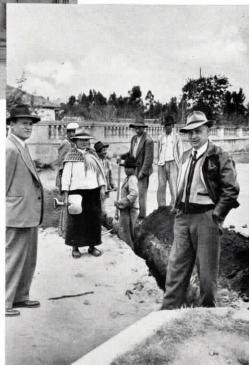
Abb.10 Erdkabelverlegung
