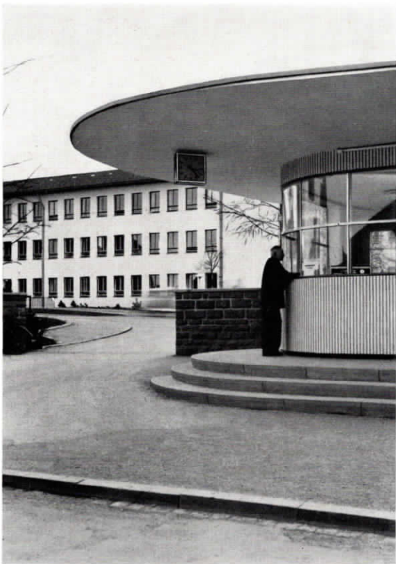
Abb. 3 Pförtnerhaus mit doppelseitiger TuN-Außenuhr
