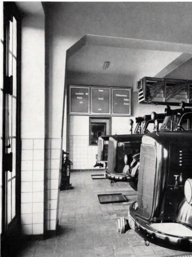
Abb. 6 Blick in die Fahrzeughalle mit dem Leuchtfeldtablo für die Einsatzbefehle
