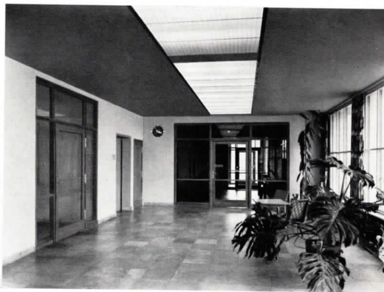
Abb. 9 Flur mit eingebauter Nebenuhr
