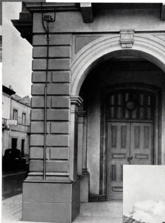
Abb. 9 Endverzweiger mit Erdkabelanschluß
