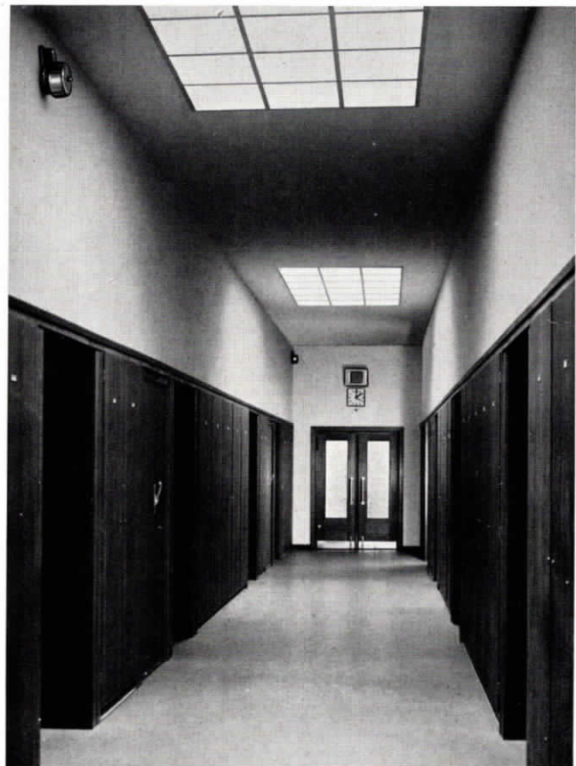
Abb. 9 Flur mit Starktonläutewerken, Lautsprecher und kombinierter Personensuch-Nebenuhr
