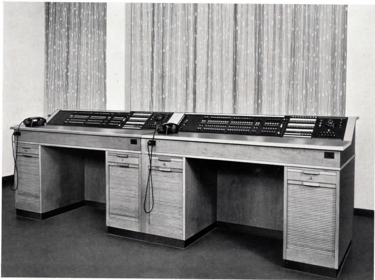
Abb.1 Ansicht der zweiplätzigen Vermittlung mit Fernmeldeschaltplatte für 20 Amtsleitungen, 400 Nebenstellen und den Betriebsleitungen, im Verwaltungsgebäude des Kommunalen Elektrizitätswerkes Mark A.G. in Hagen (Westfalen)
