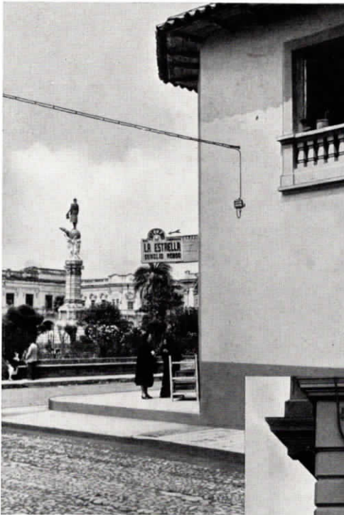
Abb. 8 Endverzweiger mit Luftkabelanschluß
