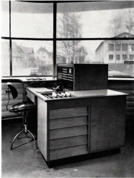
Abb. 2 Vermittlungsplatz für die Wähleranlage der Bau- stufe II G nach dem Rekordsystem, untergebracht im Pförtnerhaus
