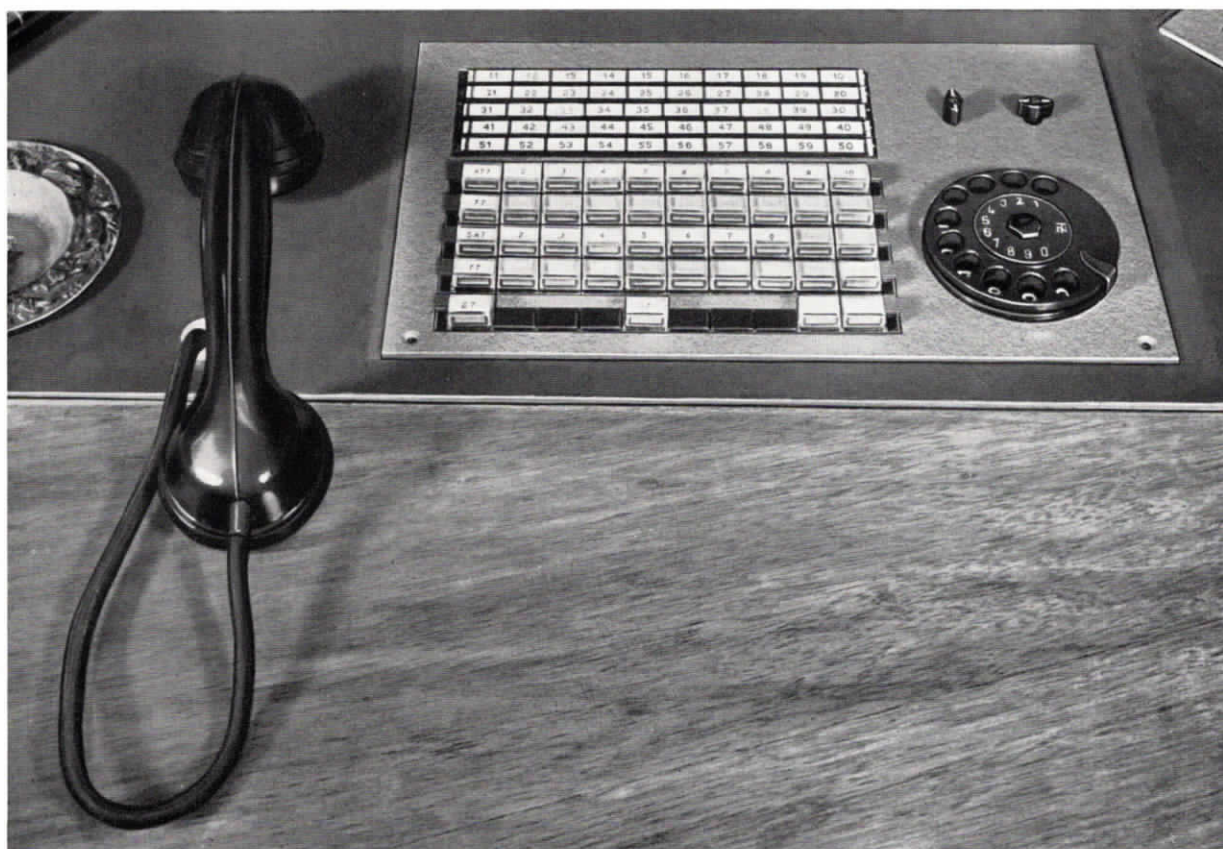
Abb. 5 Eine der 8 Einbauplatten mit Lampentasten und Besetzt-Lampen
