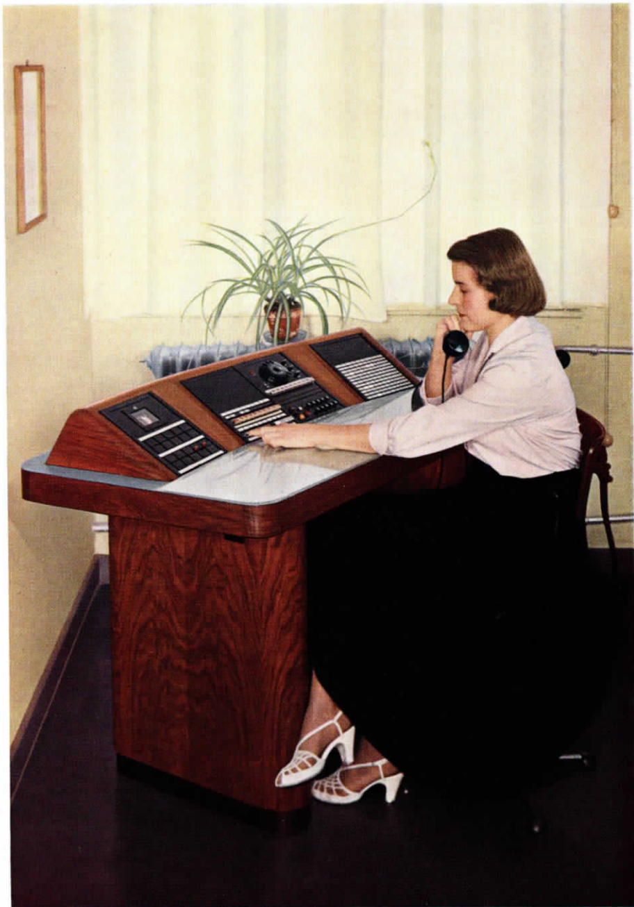
TuN-Bedienungstisch einer Großwählernebenstellen-Anlage, Baustufe 3 W in der Commerz & Discontobank, Hannover
