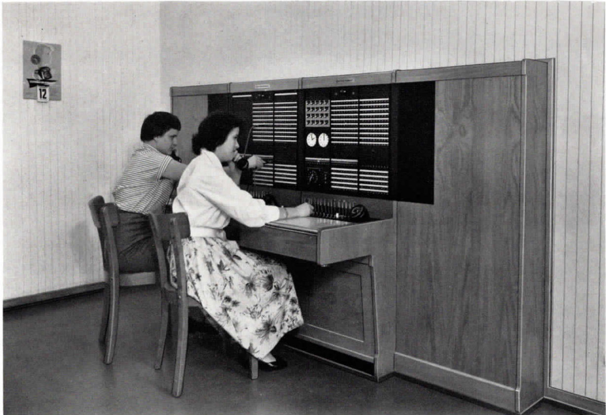
Abb. 3 Zweiplätziges Vermittlungseinrichtung nach dem Zweischnur-Rekordsystem der Baustufe III S bei Vorwerk & Co, Wuppertal-Barmen
