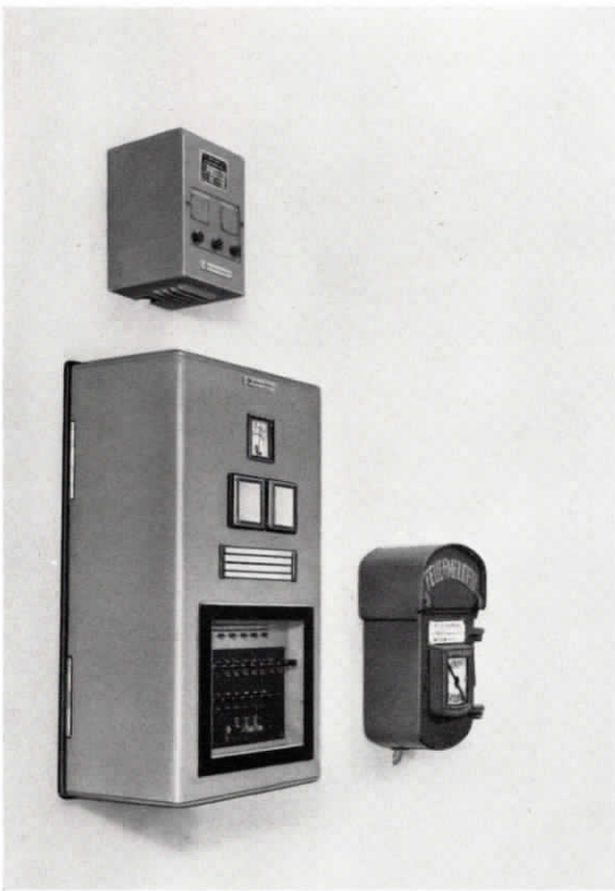
Abb. 9 Feuermeldezentrale mit öffentlichem Städt. Feuermelder bei Vorwerk & Co, Wuppertal-Barmen
