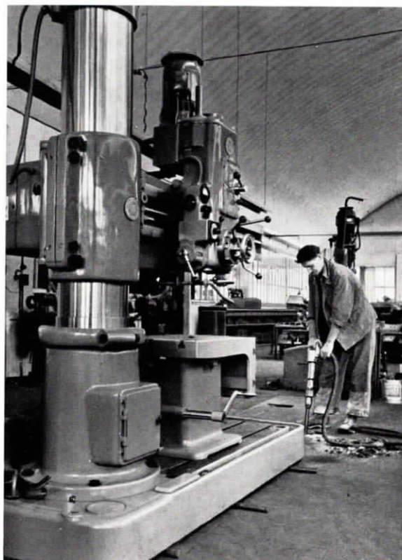
Eine neue Säulenbohrmaschine wird aufgestellt
