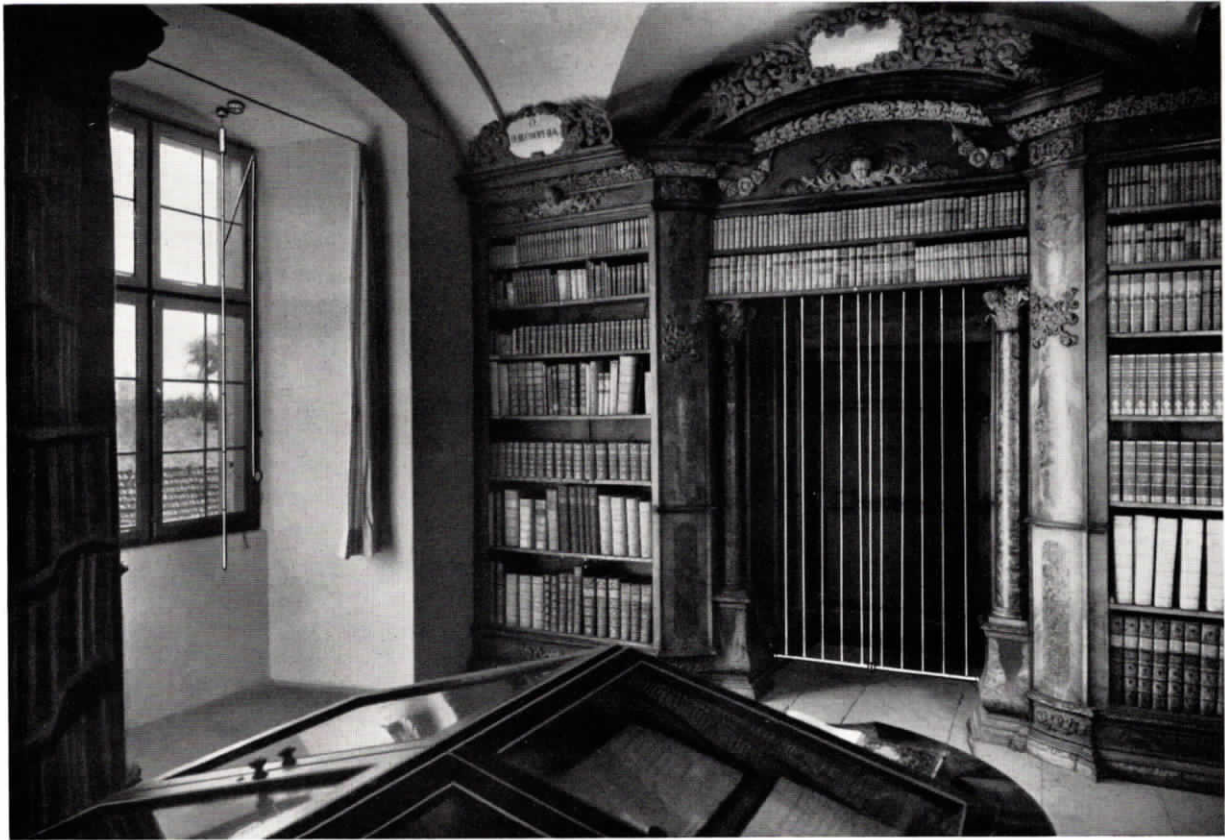
Abb. 7 Schutzeinrichtungen für Raumsicherung an Tür und Fenster, sowie für Brandschutz, im Archiv
