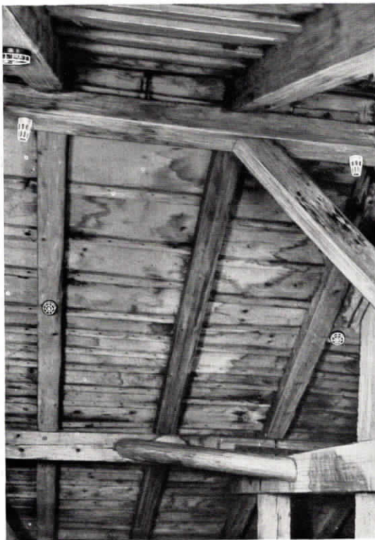
Abb. 8 Teil des Dachbodens im Museum mit verschiedenen Meldetypen für den Brandschutz
