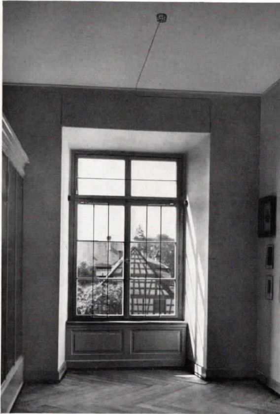
Abb. 5 Schutzeinrichtungen für Raumsicherung und Brandschutz im Museum
