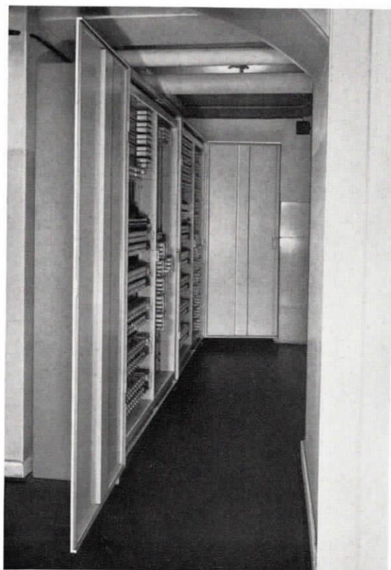
Abb. 7 Wählereinrichtungen und Relais für die Einbauplatten in geschlossener Bauweise im Kellergeschoß des Stadtbüros
