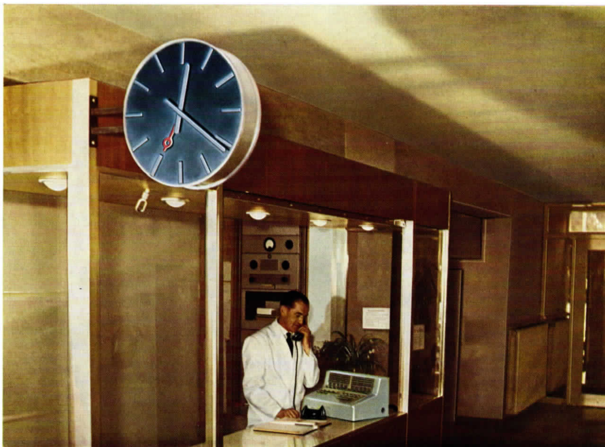
Pförtnerloge mit Vermittlungsapparat, Rundfunkzentrale und Such-Nebenuhr
