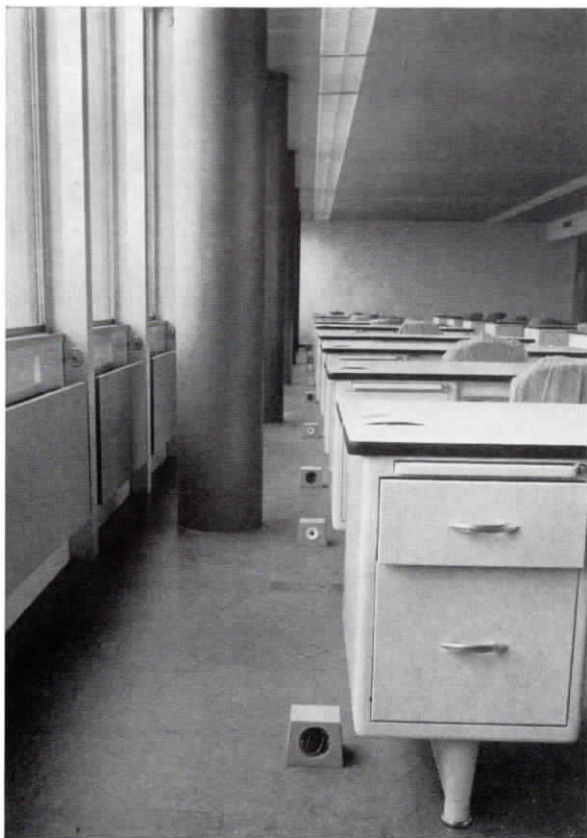
Der Teli-Tank zum Anschluß eines W-Apparates
