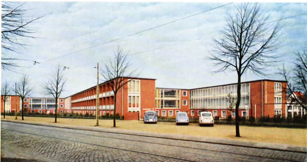
BILD 1 Gesamtansicht des Studentenwohnheimes
