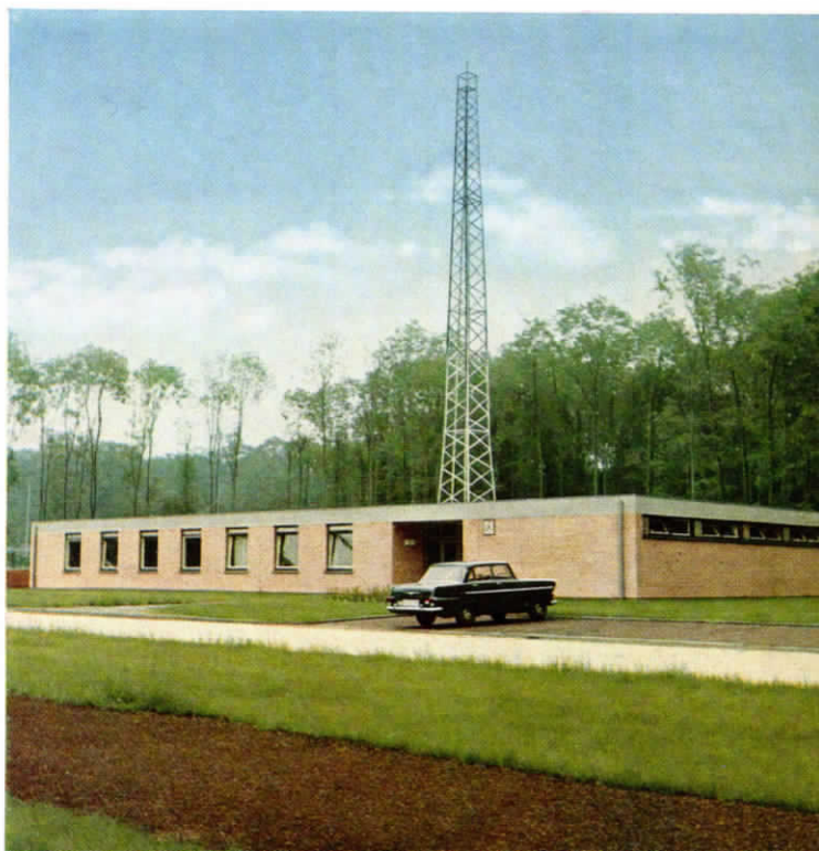
BILD 7 Antennenmast für die Sprechfunkanlage
