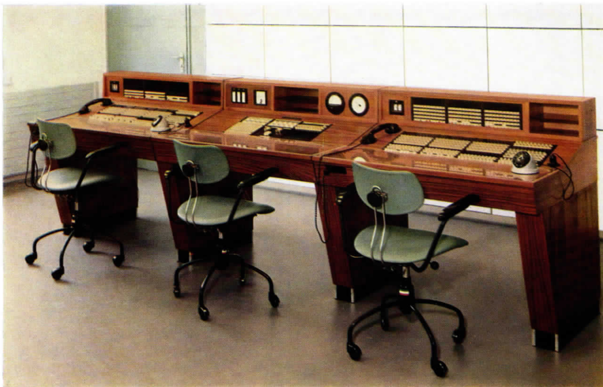
BILD 2 Bedienungsplätze der Sicherheitszentrale
