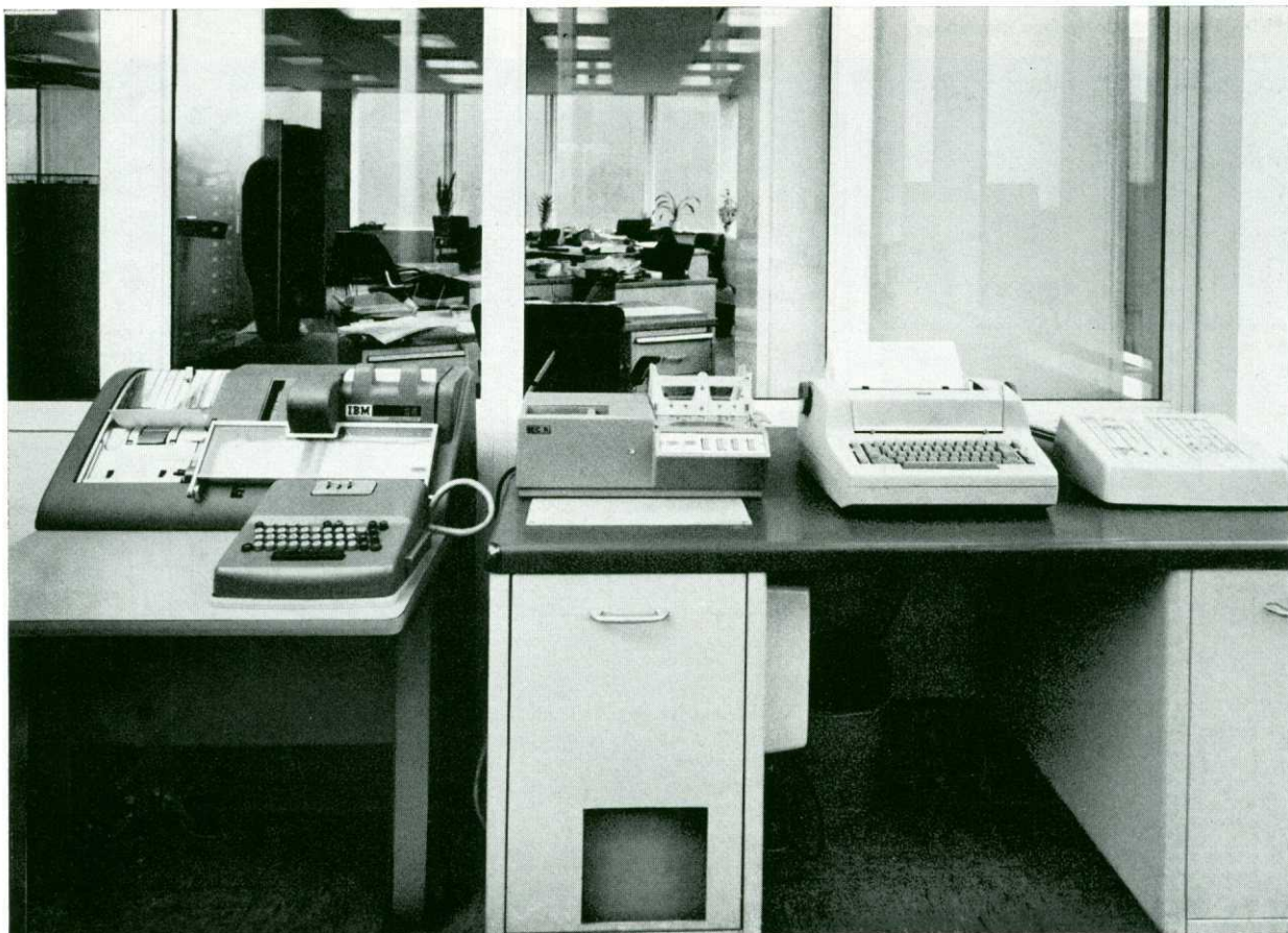
BILD 1 Datenendstation mit Lochkartenstanzer, Lochkartenleser, Schreibmaschine und Bedienungspult
