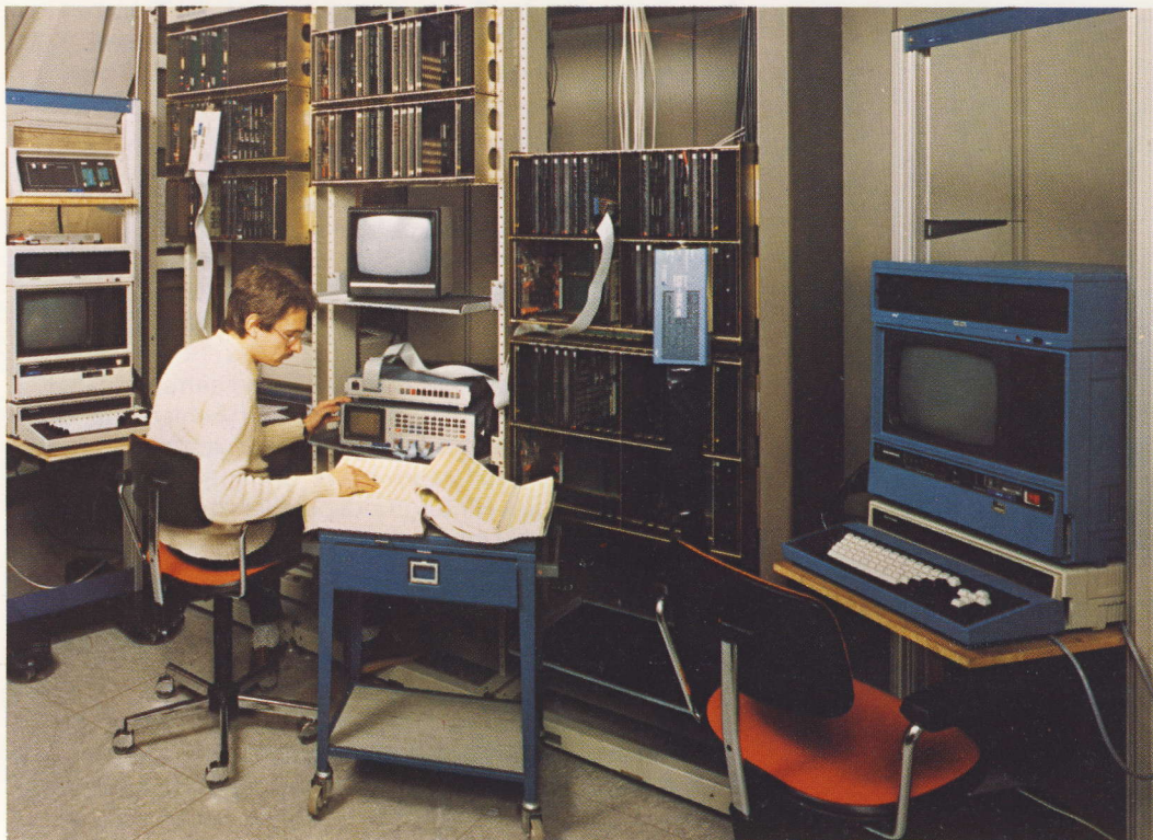
1 Prototyp der CCNC in der EWSD-Testanlage bei TN Rechts: Gestellrahmen für CCNP Links: Gestellrahmen für SILT
