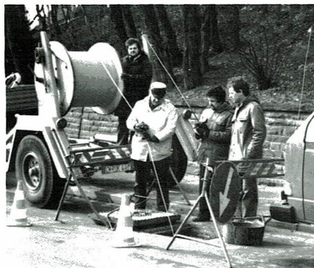
Die ersten Glasfaserkabel sind bereits verlegt.
