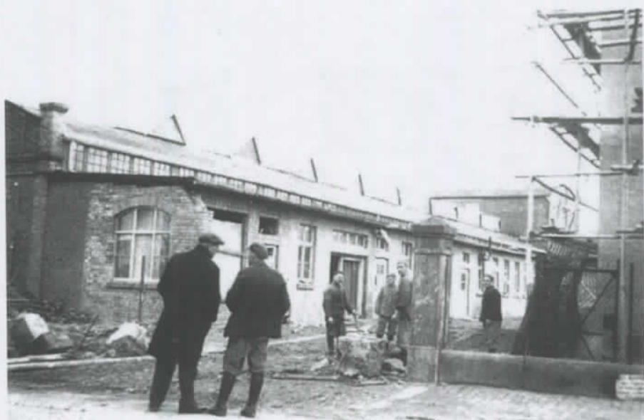
März 1941: Beginn der Umbauten für das neue Eingangsporta- tal durch Fremdarbeiter
