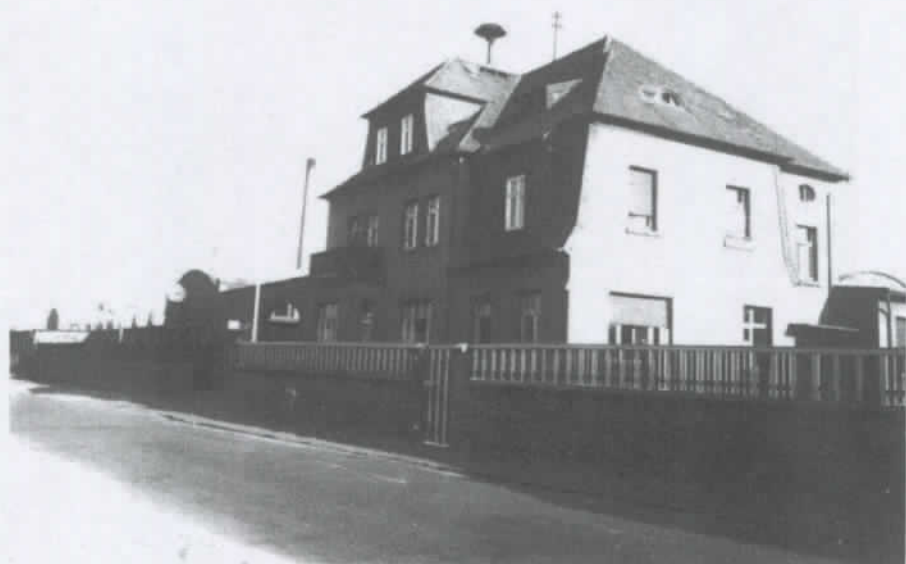
1950: Haupteingang der T&N mit Verwaltungsgebäude
