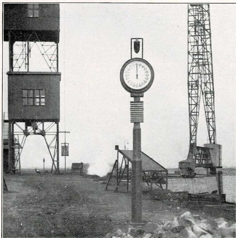
Personen-Ruf-Anlage bei der Rhenania-Ossag, Hamburg
