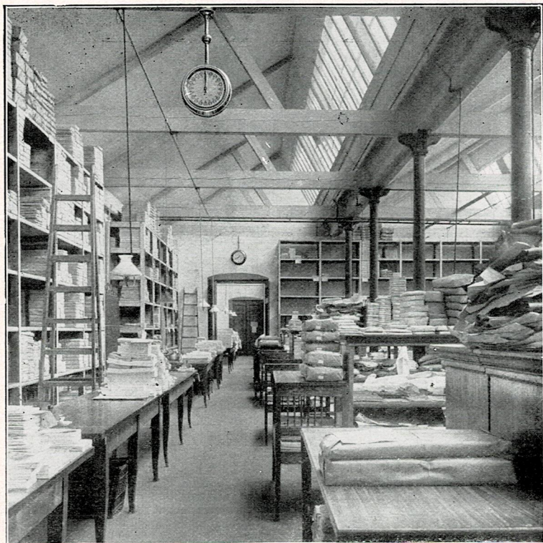
Personen-Ruf-Anlage bei der Firma S. Fränkel, Neustadt O/S Tischzeug-Leinwand- und Frottierwaren-Fabrik
