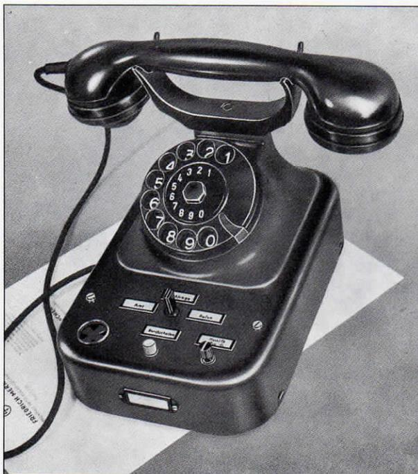
Hauptstelle zum Zwischenumschalter W 33a, Postmodell mit einer Amtsleitung und zwei Sprechstellen
