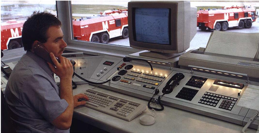
**1987** Flughafen Frankfurt TN Mehrfach Abfrage in der Zentrale für Feuermeldung; Notruf und Überwachung mit TM 4030. Auch mit Einsatz vom KV / EV Material. Auf dem neuen Flugplatz in München wurde eine gleichartige TN Zentrale eingebaut.
